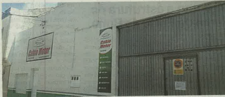
CABÍO MOTOR. Fachada del taller Cabío Motor, en el que se produjo el incendio. Foto: G.
